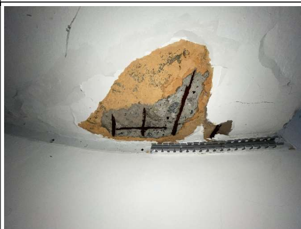
ARMADURA EXPOSTA
